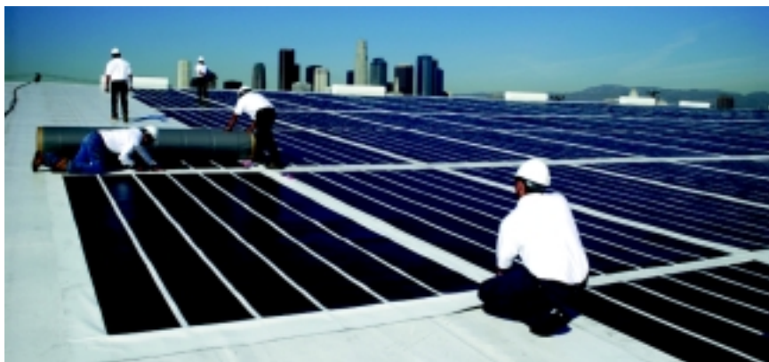
Amorfsest silikoonist ja polümeersest katuserullmaterjalist valmistatud õhukesi rullitavaid ja kleebitavaid päikesepatareiseid on lihtne paigaldada. Foto: Henkel
